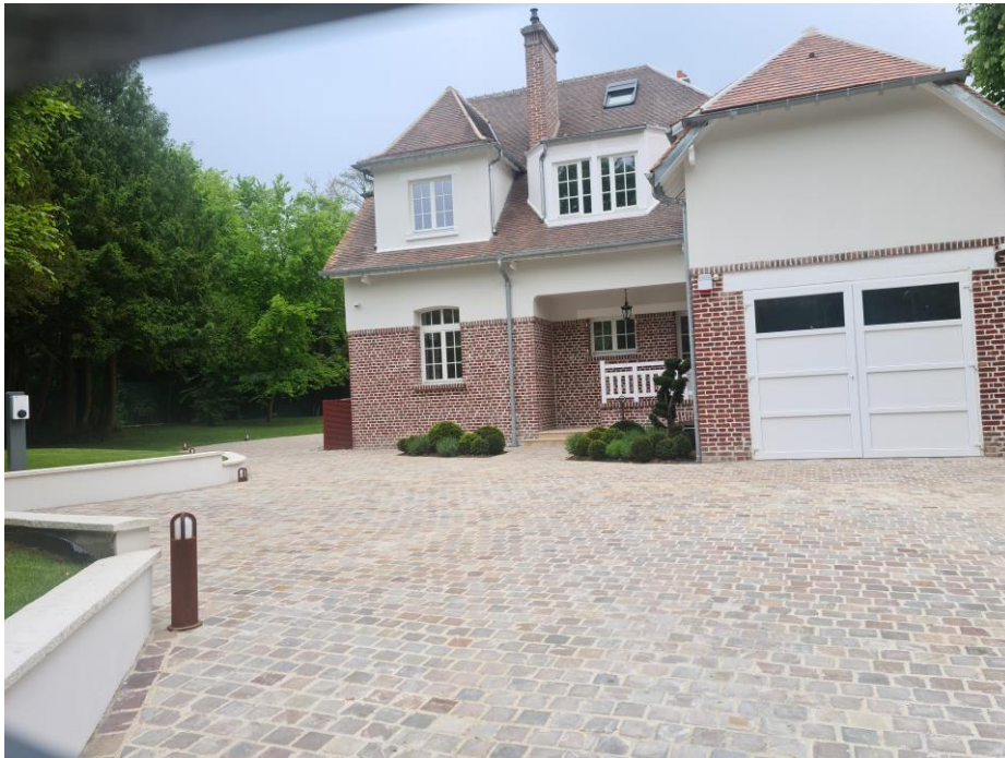
Rénovation totale des extérieurs et allées
